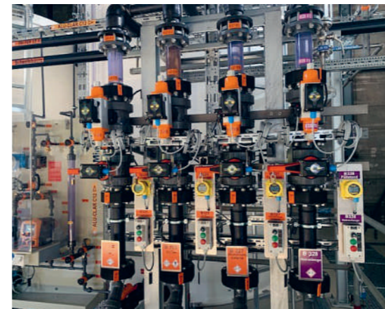
Erneuerung Dosiertanks.
